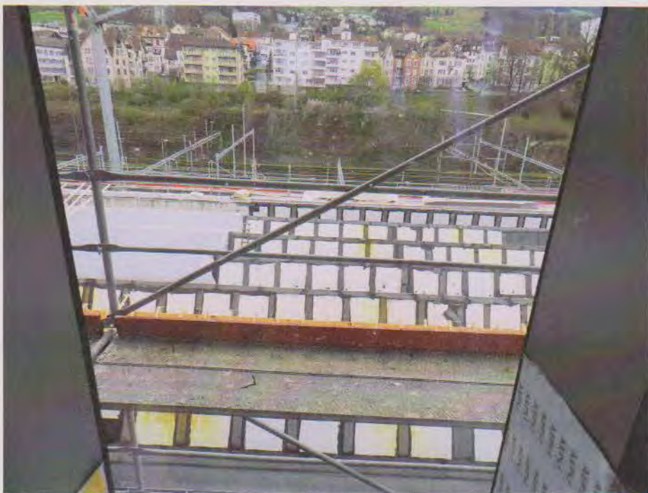
Stahl-Fachwerkträger, die den Haupteingang überdecken.
