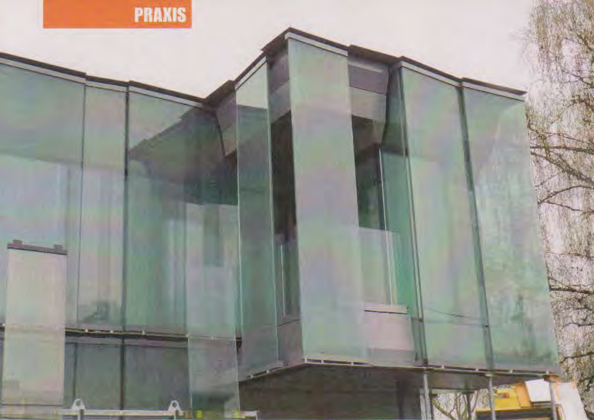
Ein erstes Muster für die Glasfassade.
