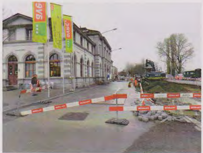
Die Kantonsstrasse neben dem Würth-Areal wird saniert.
