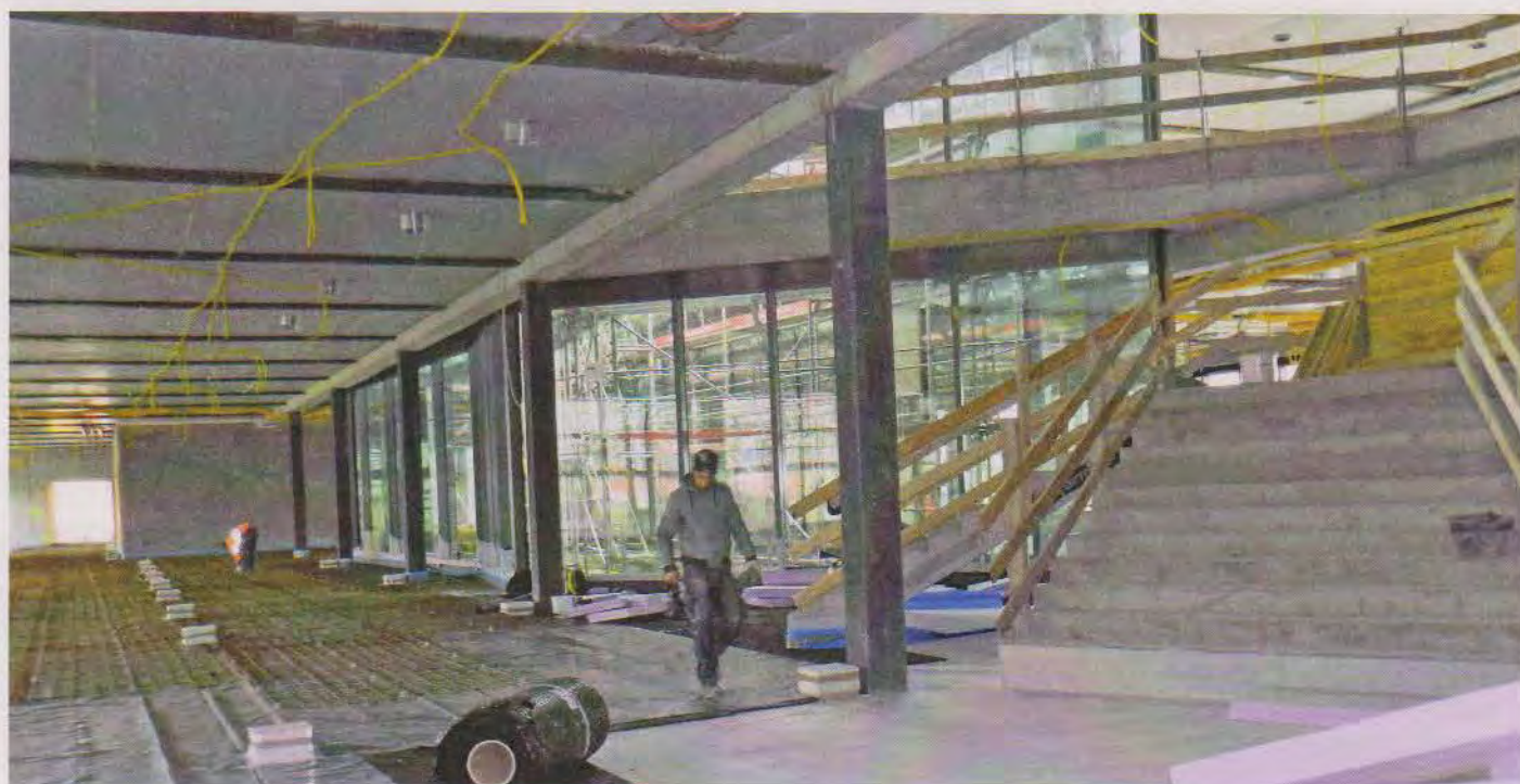
Im Empfangsbereich wird der Boden eingegossen.
